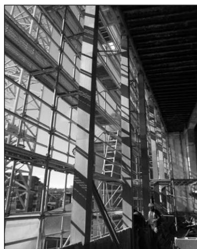
Foto n° 4 e n° 5: incamiciatura di travi e di pilastri a sezione snella con microcalcestruzzo REFOR-tec
