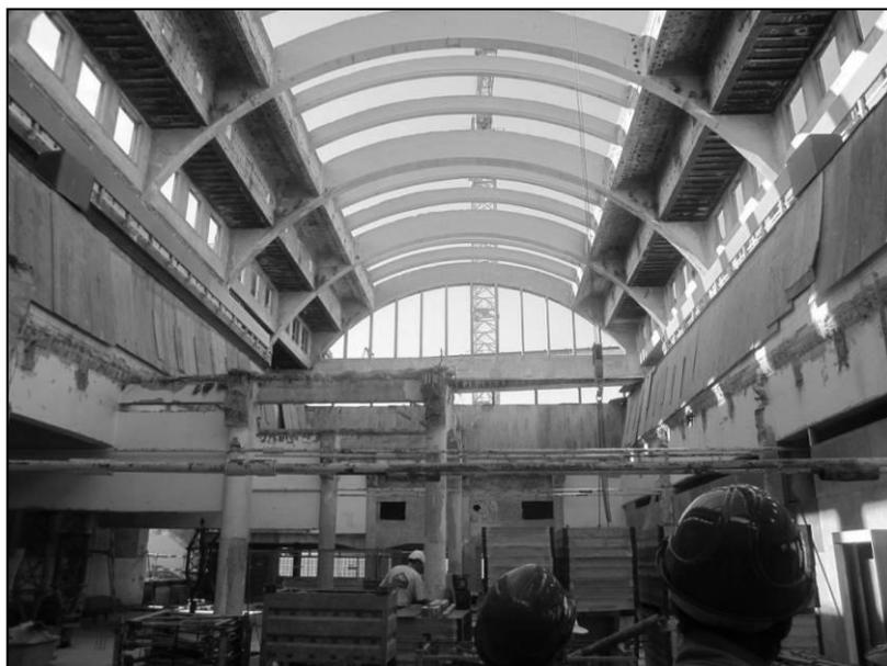
oggi recuperati e rinforzati con tecnologia REFOR-tec, segnaliamo che i test di resistenza al fuoco appena descritti, sono stati propedeutici alla realizzazione di un'importante ristrutturazione / adeguamento strutturale di un edificio storico di Liegi (Mnèma Historic Building) trasformato da piscina pubblica a museo/sala congressi (foto n° 2, 3, 4, 5)
